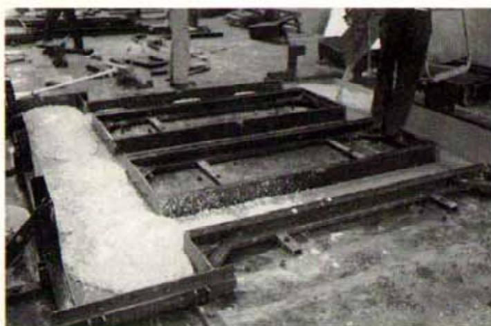
12 - La cassaforma utilizzata per la prefabbricazione di un pannello portante di facciata; 13 - Il disarmo di un pannello; 14-15-16 - Assemblaggio in opera dei pannelli di facciata di 3,80 m di altezza, sui perni di centraggio preventivamente disposti sulla trave perimetrale; 17 - Montaggio di un elemento di coronamento; 18 - La costruzione del controventamento scatolare in c.a. gettato in opera.
