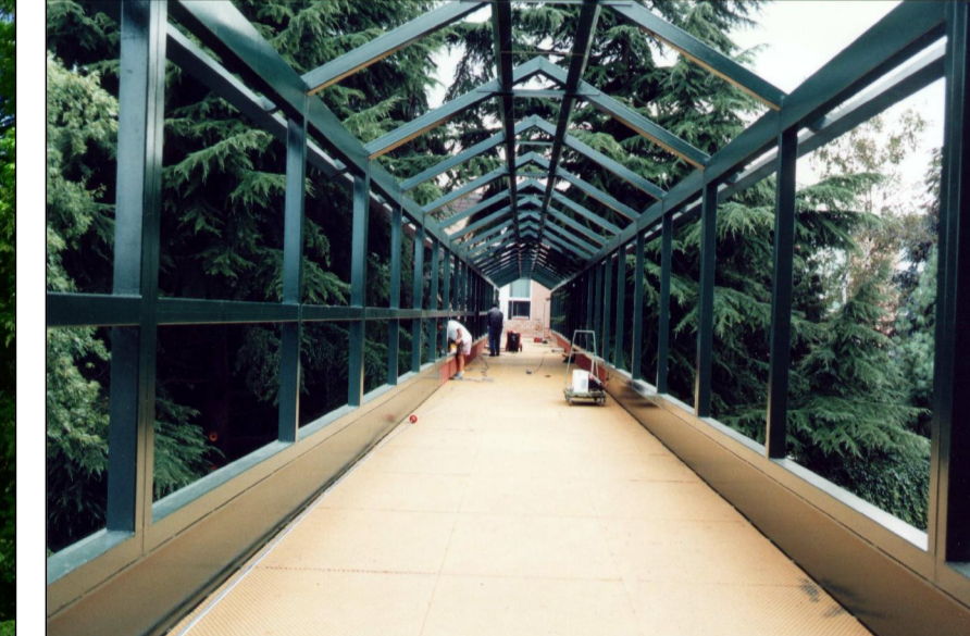
PONTE TRA ALBERGO E RISTORANTE IN FASE DI REALIZZAZIONE
