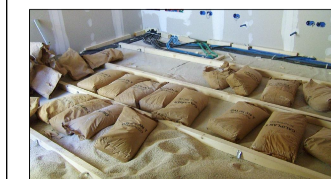
10. 11. ESECUZIONE MASSETTI A SECCO E POSA LASTRE PIANE
