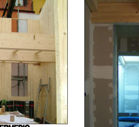
12. PARETI INTERNE IN CARTONGESSO E ESECUZIONE IMPIANTI AL SECONDO PIANO
