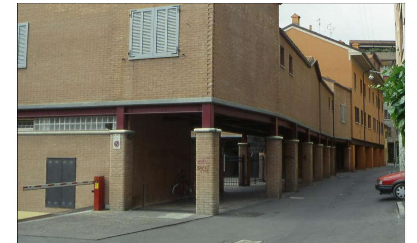
PORTICO SU VIA SAN ROCCO
