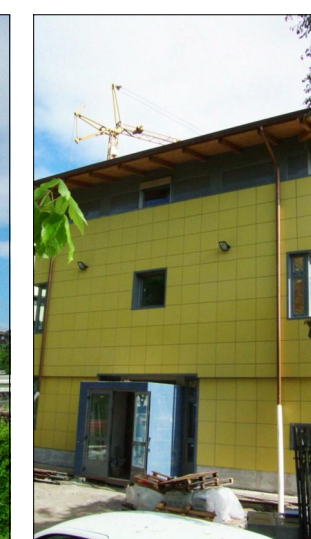
VISTA DEL PROSPETTO OVEST
