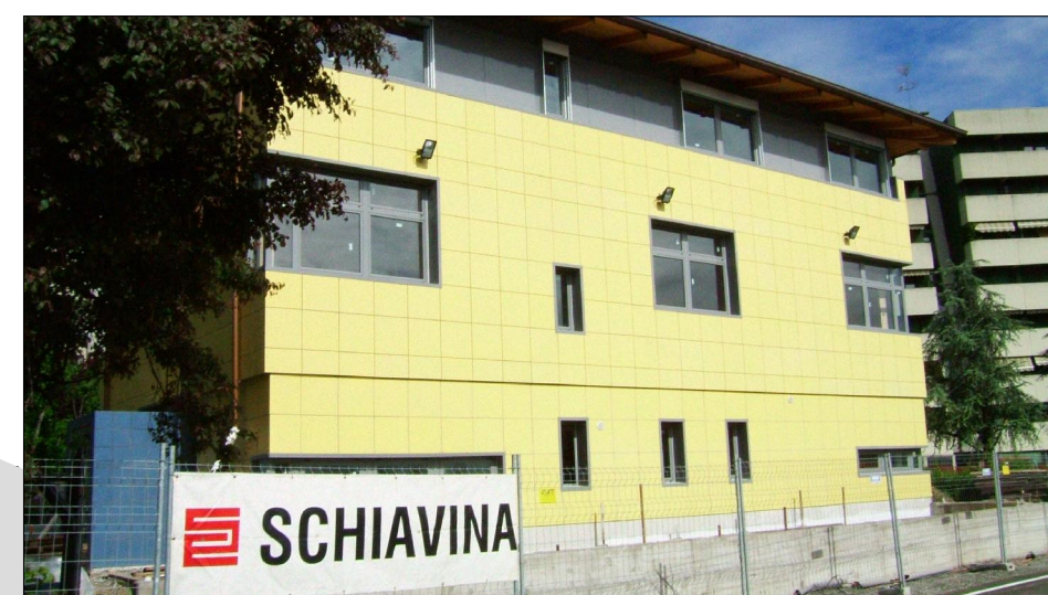
VISTA DEL PROSPETTO EST
