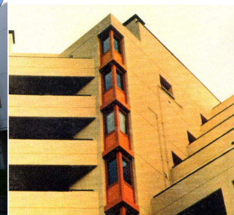
DETTAGLIO FINESTRA AD ANGOLO
